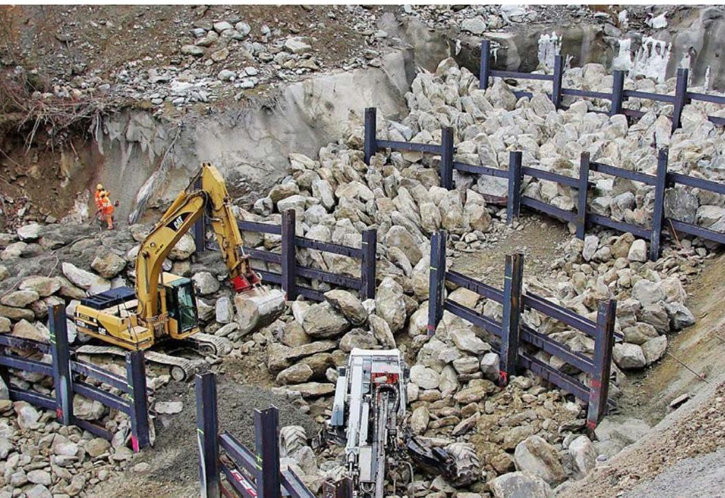
**Construction d'un ouvrage destiné à freiner les laves torrentielles qui descendent dans le Spreitgraben, près du village bernois de Guttannen, dans le Haslital. Ce dispositif métallique en forme de barrières laisse passer l'eau et retient les matériaux solides des laves torrentielles.**
