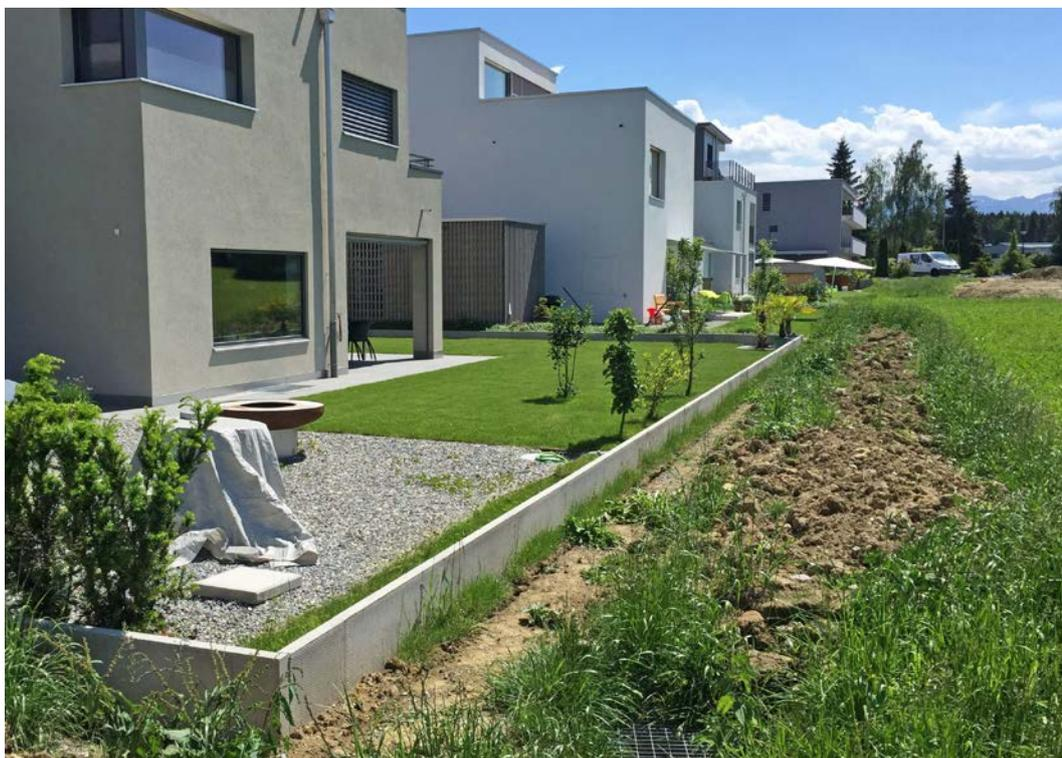
**Dispositif de protection contre le ruissellement de surface installé après un orage qui a inondé la cave en causant pour 200 000 francs de dommages. La carte dite de l'aléa ruissellement aide aujourd'hui les concepteurs à éviter de tels dommages.**
