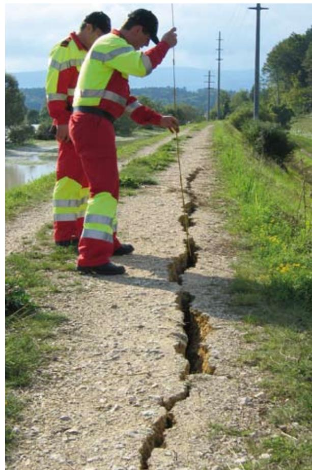
**Schäden an einem Hochwasserschutzdamm am Hagneckkanal im Berner Seeland. Nach einer vertieften Ereignisanalyse wird das Bauwerk seit Ende 2010 umfassend saniert.**
