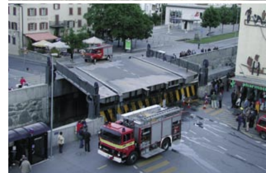
Ouvrages de protection au-dessus de Täsch VS. Le pont levant construit sur la Saltina à Brigue peut être soulevé en cas de crue. Une bonne organisation du service militaire contribue également à la réduction des dégâts.
