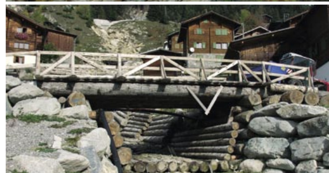
Dommages catastrophiques provoqués par une coulée de boue à Schlans GR (11/2002). Les mesures d'urgences effectuées offrent une protection provisoire à la population. Une nouvelle digue construite à Rueun GR offre une plus grande sécurité aux habitants.
