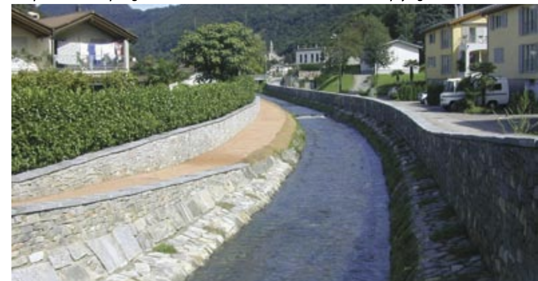
Un nouveau bâtiment construit dans une zone à risques des environs de Lugano TI après les intempéries de juillet 2001. Protection de la zone habitée de Pian Scairolo TI. Le torrent peut évacuer un plus grand débit d'eau sans intervenir massivement dans le paysage.
