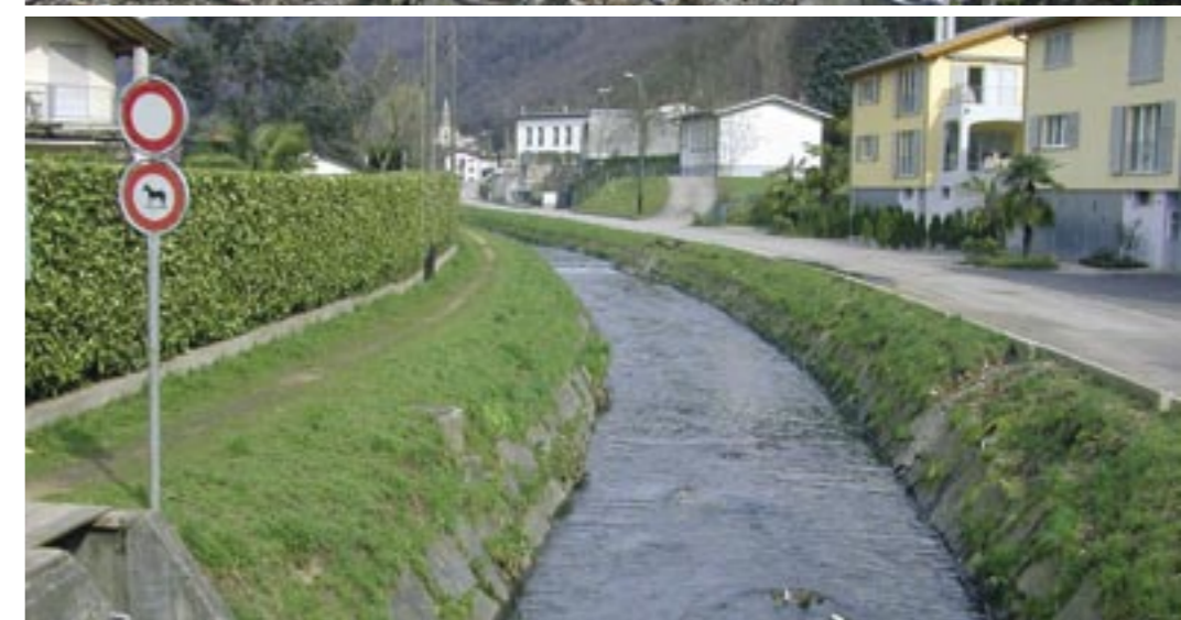
Un nouveau bâtiment construit dans une zone à risques des environs de Lugano TI après les intempéries de juillet 2001. Protection de la zone habitée de Pian Scairolo TI. Le torrent peut évacuer un plus grand débit d'eau sans intervenir massivement dans le paysage.
