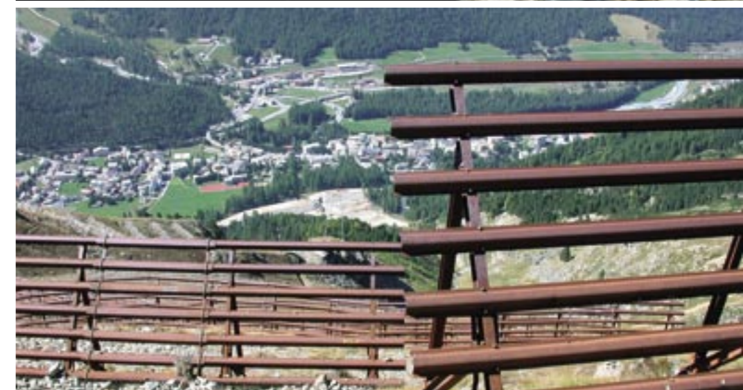
L'avalanche de Täsch VS. Les installations du Schafberg et la nouvelle digue protègent Pontresina GR contre les avalanches, les chutes de pierre et les laves torrentielles.
