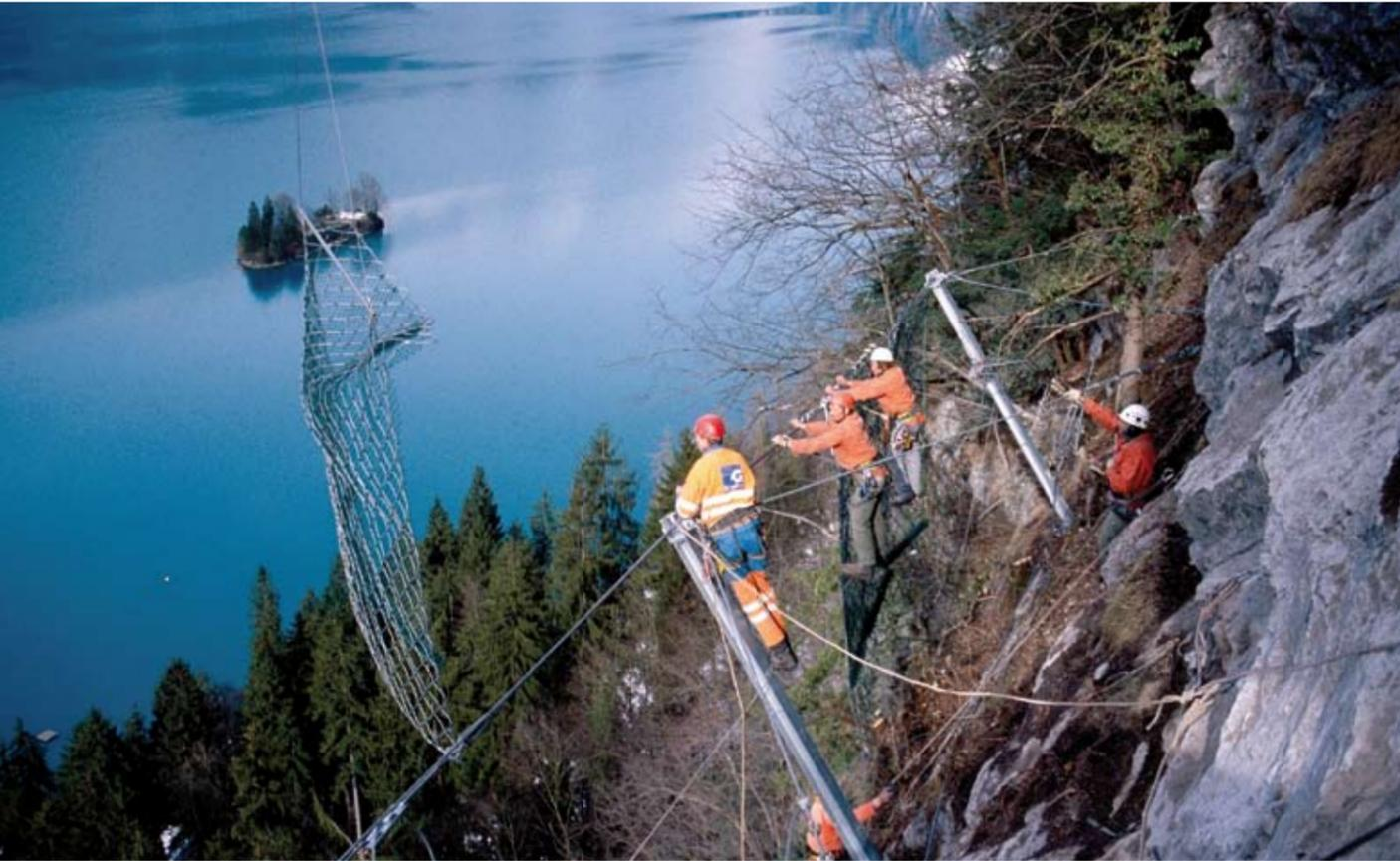
Montaggio di una rete paramassi per la messa in sicurezza dell'autostrada sulla sponda meridionale del Lago di Brienz.
