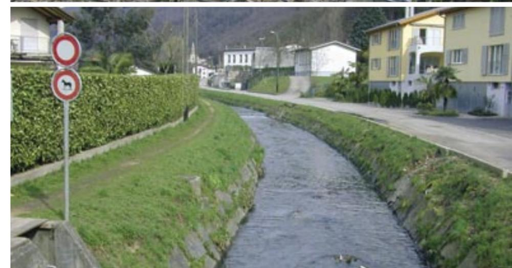
Costruzione nell'entroterra di Lugano TI dopo il maltempo del luglio 2001. A protezione dell'agglomerato da forti precipitazioni il corso d'acqua nel Pian Scairolo TI è in grado di convogliare in futuro più acqua senza deturpare in modo sensibile il paesaggio.
