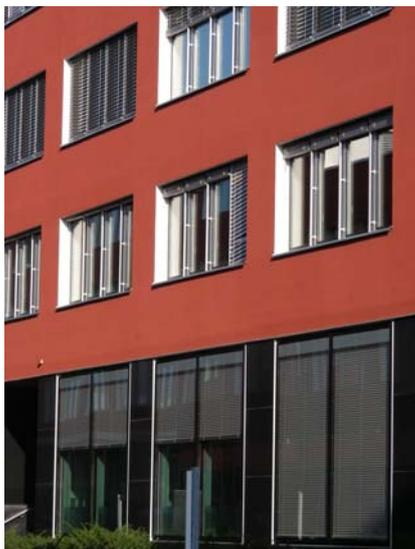
*Abbildung 41: Lamellenstoren geschützt zwischen Glas (unten) und aussen, dem Wetter ausgesetzt (oben) (Quelle: D. Aller).*
