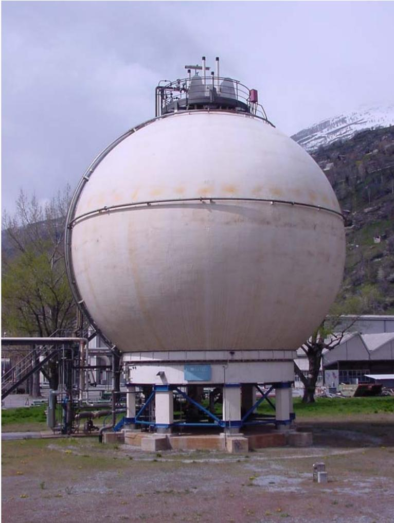
*Abbildung 37: Das blaue Stahlgerüst schützt den Flüssiggastank zusätzlich vor den Einwirkungen von Erdbeben (Quelle: Lonza AG, Ereignisdienste).*
