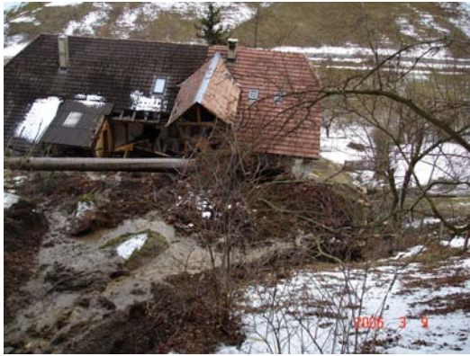
(c) Rückstau durch das Gebäude.
