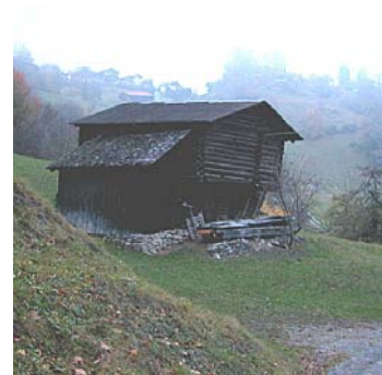
(c) Gebäude auf Kriechhang innerhalb einer tiefgründigen permanenten Rustchmasse. Dank den duktilen Bauteilen aus Holz wird das Gebäude nicht zerrissen, sondern macht die Bewegung mit und steht schief.
