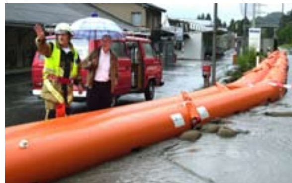
Per ottenere lo stesso grado di protezione di un chilometro di sbarramento mobile sarebbero necessari 75 mila sacchi di sabbia.
