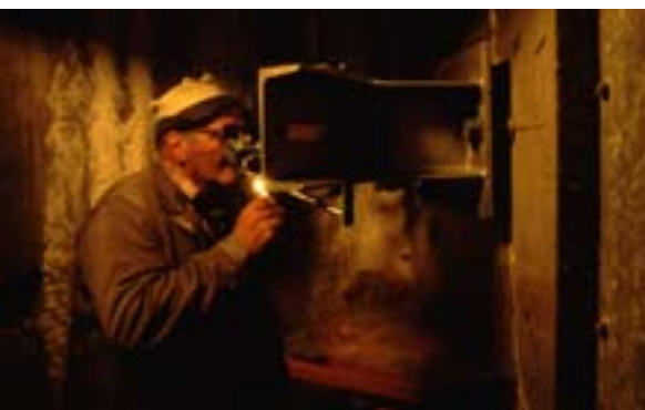
Cunicolo di controllo all'interno della diga.
