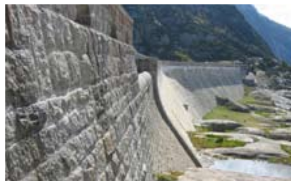
Les barrages font partie des ouvrages les mieux surveillés de Suisse.
