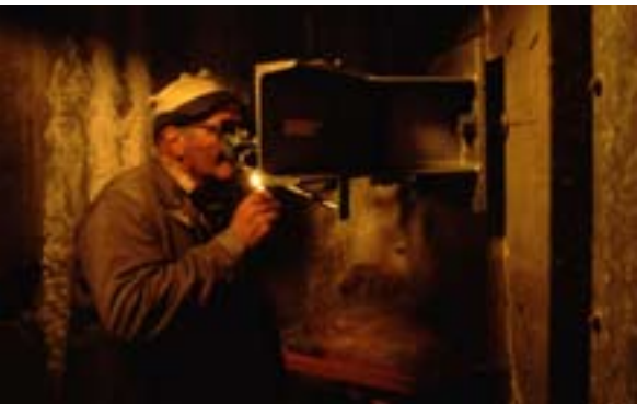
Ronde de contrôle dans le barrage.
