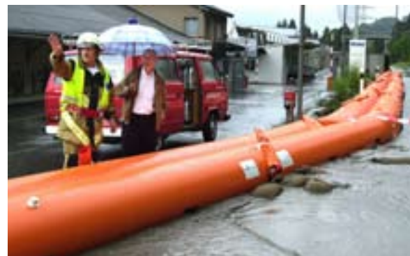
1000 mètres du système mobile correspond à environ 75 000 sacs de sable.
