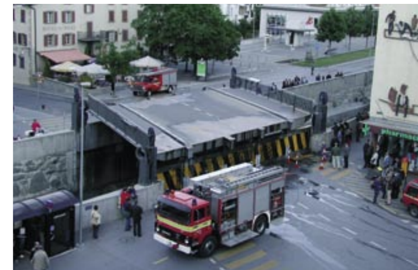
Bauliche Schutzmassnahme ob Täsch VS. In Brig wird die Hubbrücke über die Saltina bei Hochwasser automatisch angehoben. Auch bei Naturereignissen trägt die gute Organisation der Wehrdienste zur Schadenreduktion bei.
